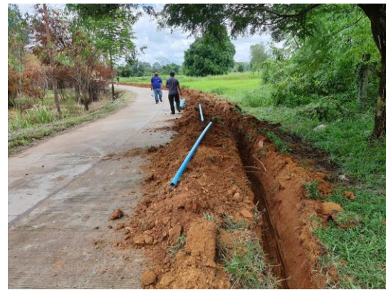
ชุมชนบ้านหวาย ดำเนินการจ้างเหมารถแบคโฮขุดดิน และวางท่อ PVC ระยะทาง 400 เมตร โดยดำเนินงานระหว่างวันที่ 1- 10 สิงหาคม 2564
