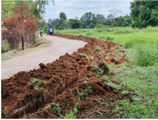
ชุมชนบ้านหวาย ดำเนินการจ้างเหมารถแบคโฮขุดดิน และวางท่อ PVC ระยะทาง 400 เมตร โดยดำเนินงานระหว่างวันที่ 1- 10 สิงหาคม 2564
