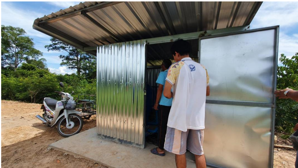
ชุมชนร่วมกันตรวจสอบความเรียบร้อยของอาคารถังแรงดัน
