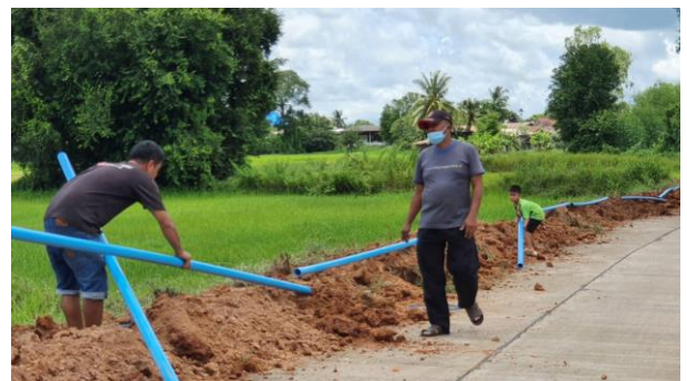
ชุมชนร่วมกันวางท่อ PVC เพื่อเตรียมการประสานท่อด้วยน้ำยาประสานท่อ
