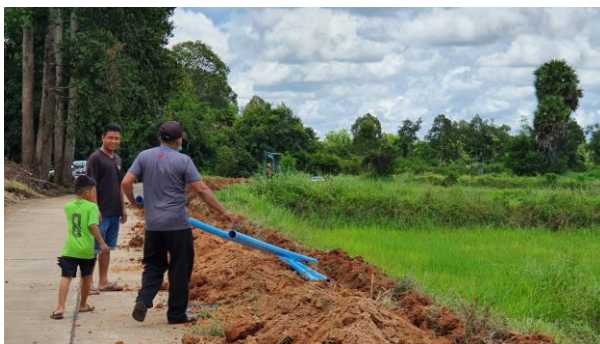
ชุมชนร่วมกันวางท่อ PVC เพื่อเตรียมการประสานท่อด้วยน้ำยาประสานท่อ
