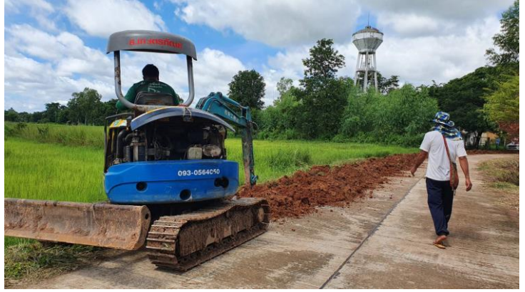
ชุมชนบ้านหวาย ดำเนินการจ้างเหมารถแบคโฮขุดดิน และวางท่อ PVC ระยะทาง 400 เมตร โดยดำเนินงานระหว่างวันที่ 1- 10 สิงหาคม 2564
