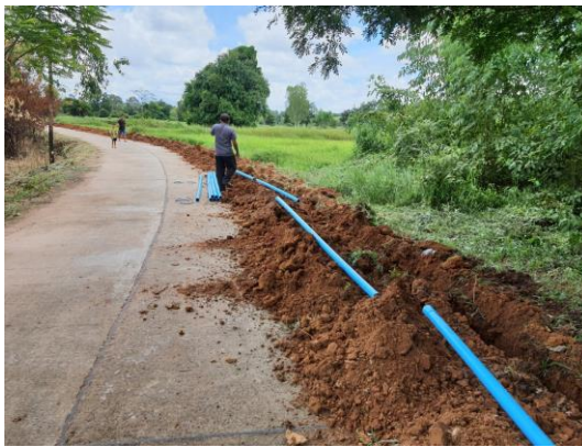
ชุมชนบ้านหวาย ดำเนินการจ้างเหมารถแบคโฮขุดดิน และวางท่อ PVC ระยะทาง 400 เมตร โดยดำเนินงานระหว่างวันที่ 1- 10 สิงหาคม 2564
