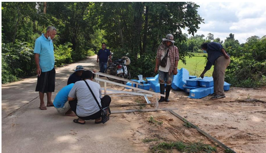
ชุมชนร่วมกันประกอบและติดตั้งฐานแผงโซลาเซลล์
