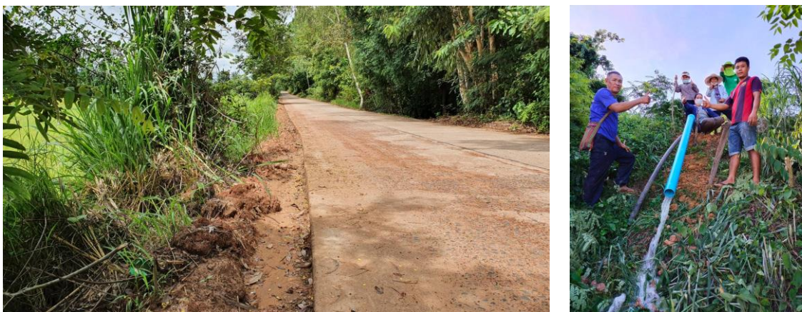
ชุมชนร่วมกันตรวจสอบความเรียบร้อยงานวางท่อ PVC
