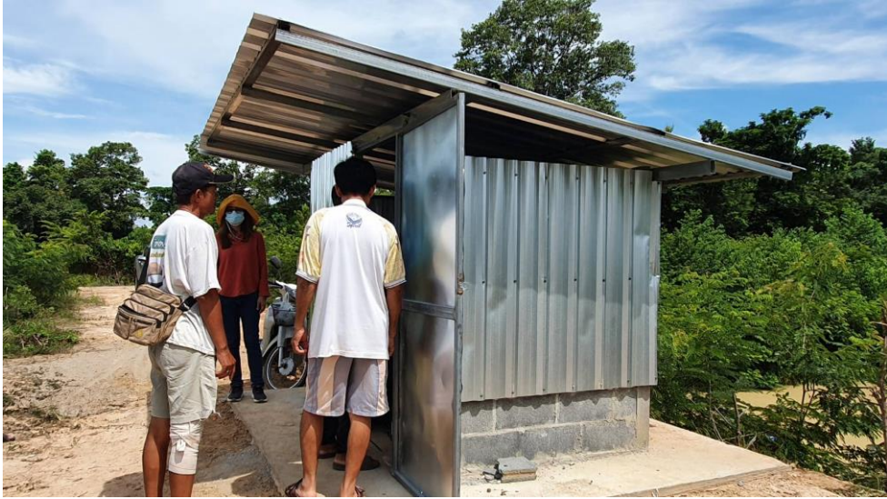
ชุมชนร่วมกันประกอบหลังคาและติดตั้งประตูอาคารถังแรงดัน
