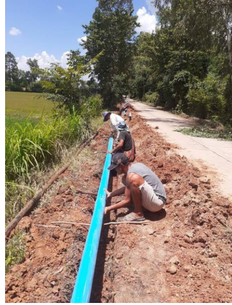
ชุมชนร่วมกันประสานท่อด้วยน้ำยาประสานท่อ PVC เพื่อเพิ่มความแข็งแรง
