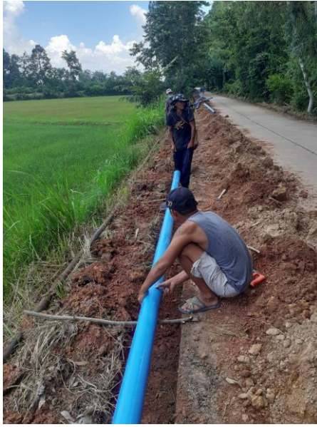
ชุมชนร่วมกันประสานท่อด้วยน้ำยาประสานท่อ PVC เพื่อเพิ่มความแข็งแรง
