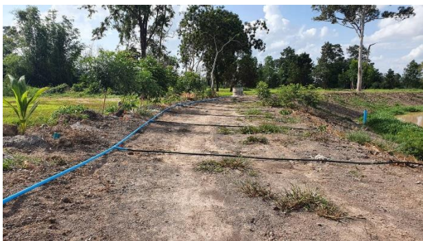
ชุมชนร่วมกันประกอบท่อ PE และติดตั้งสปริงเกอร์ระบบกระจายน้ำภายในแปลง
