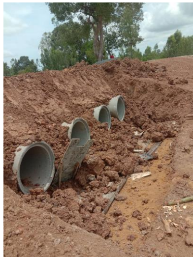
ชุมชนร่วมกันวางท่อ กลบดินฝังท่อพร้อมผูกเหล็กเตรียมเทพื้นอาคารหน้าท่อ
