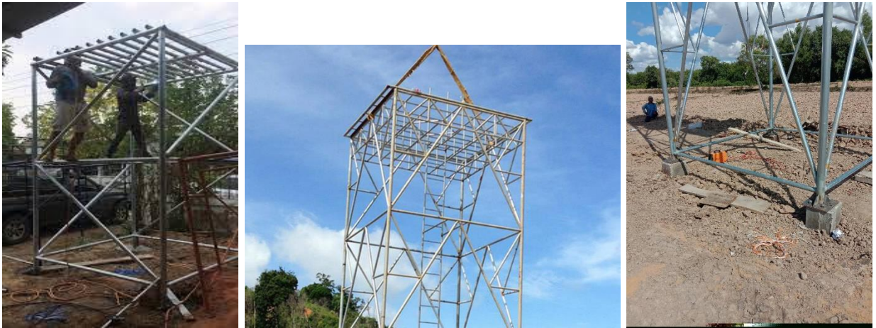
ชุมชนร่วมกันประกอบและติดตั้งอาคารหอถังสูง 7.5 เมตร
