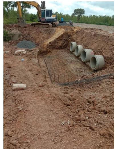
ชุมชนร่วมกันวางท่อ กลบดินฝังท่อพร้อมผูกเหล็กเตรียมเทพื้นอาคารหน้าท่อ
