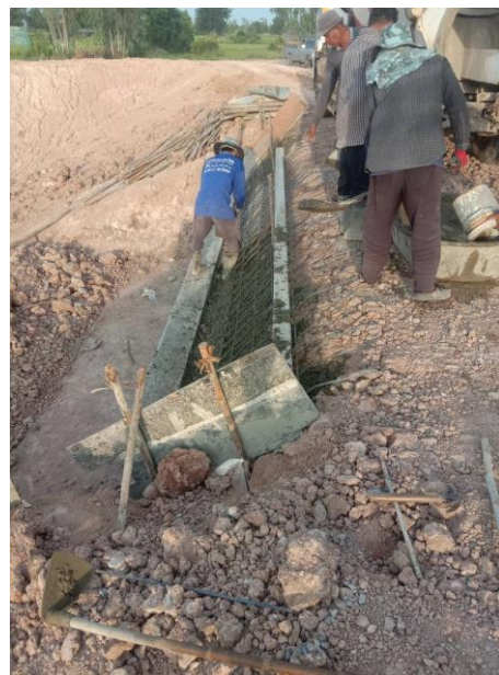
ชุมชนร่วมกันผูกเหล็กมัดลวด และเทพื้นอาคารหน้าท่อ (ด้านบน)
