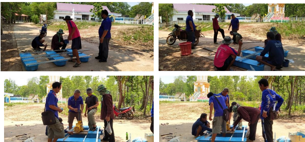
ชุมชนร่วมกันประกอบทุ่นลอยน้ำ ติดตั้งเครื่องสูบน้ำหยิ่ง
