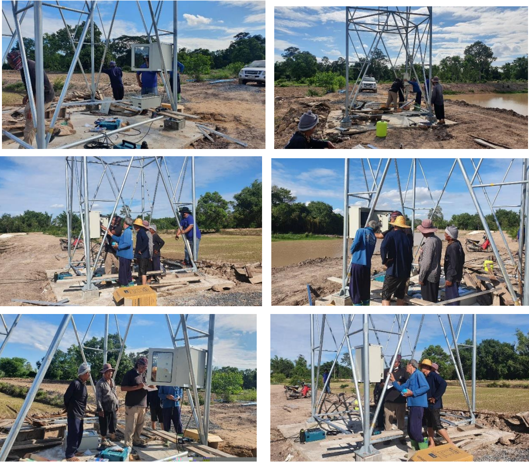
คณะกรรมการบริหารจัดการทรัพยากรน้ำชุมชนบ้านศรีฐาน ตำบลศรีฐาน ร่วมกันประกอบและติดตั้งชุดควบคุมระบบสูบน้ำพลังงานแสงอาทิตย์ และเรียนรู้การทำงานของแผงควบคุมระบบสูบน้ำพลังงานแสงอาทิตย์
