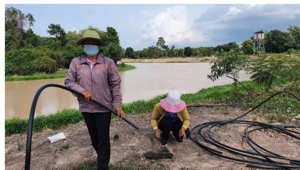
ชุมชนร่วมกันเตรียมท่อ PVC ขนาด 2 นิ้ว และท่อ PE เพื่อประกอบระบบกระจายน้ำในแปลง
