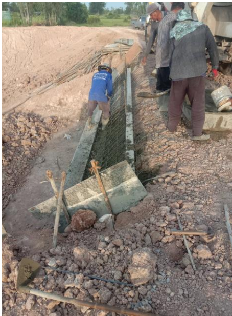
ชุมชนร่วมกันผูกเหล็กมัดลวด และเทพื้นอาคารหน้าท่อ (ด้านบน)
