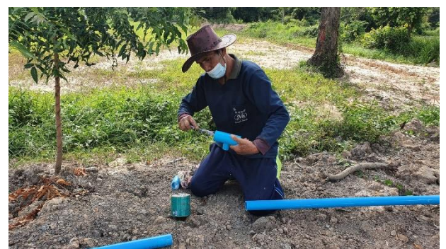
ชุมชนร่วมกันเตรียมท่อ PVC ขนาด 2 นิ้ว และท่อ PE เพื่อประกอบระบบกระจายน้ำในแปลง
