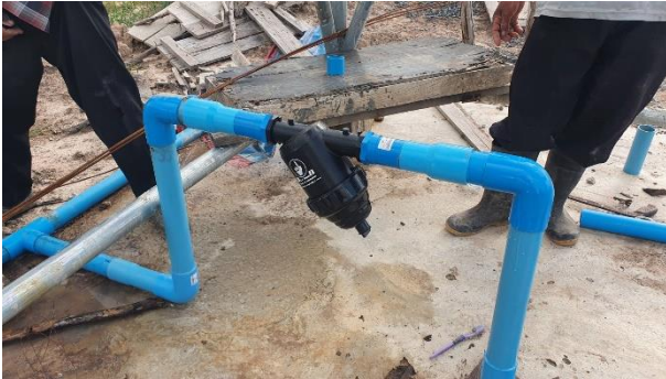
ชุมชนร่วมกันติดตั้งชุดควบคุมหัวน้ำ ตัวกรองน้ำเกษตร (จุดที่ 2) เพื่อกรองเศษดิน เศษหินที่จะเข้าไปในถังบรรจุน้ำ
