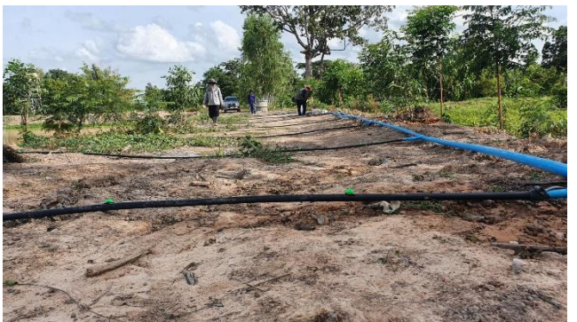
ชุมชนร่วมกันประกอบท่อ PE และติดตั้งสปริงเกอร์ระบบกระจายน้ำภายในแปลง
