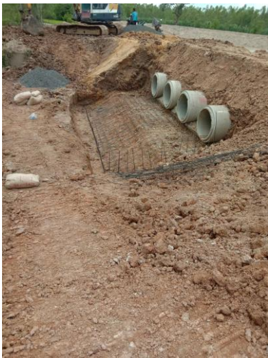
ชุมชนร่วมกันวางท่อ กลบดินฝังท่อพร้อมผูกเหล็กเตรียมเทพื้นอาคารหน้าท่อ
