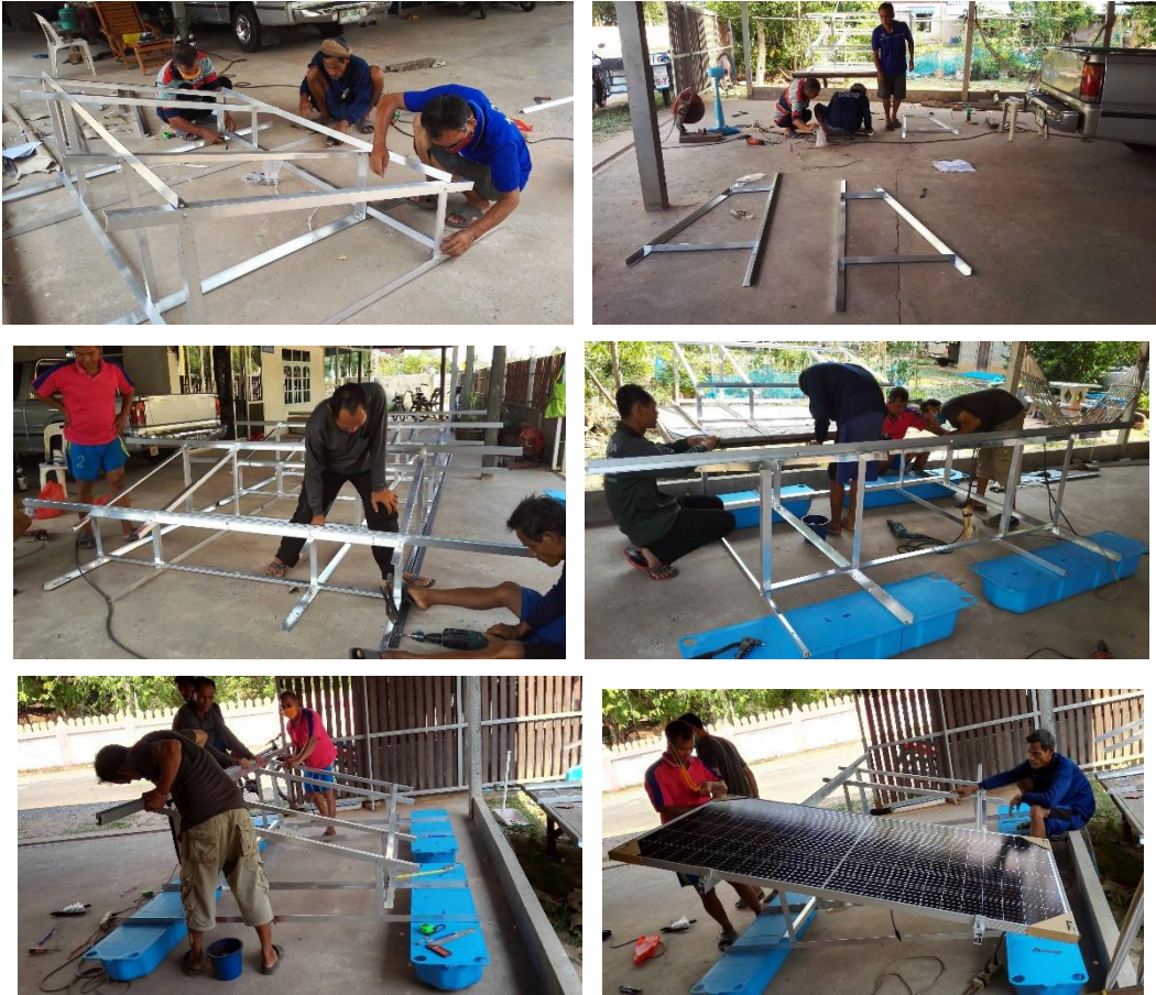
ชุมชนร่วมกันประกอบและติดตั้งฐานติดตั้งโซลาเซลล์ ทุ่นลอยน้ำ และแผงโซลาเซลล์
