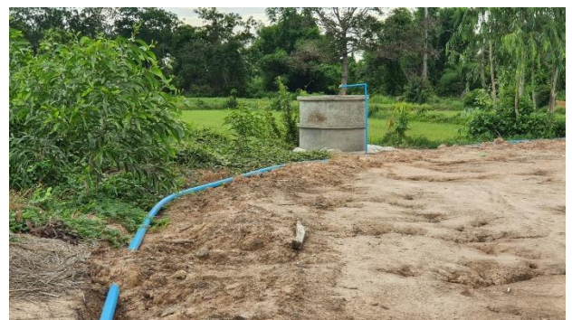
ชุมชนร่วมกันวางระบบท่อ PVC ขนาด 2 นิ้ว ท่อประธาน) และถังเก็บน้ำคอนกรีตเสริมเหล็ก (บ่อวงซีเมนต์)
