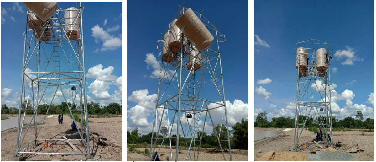
ชุมชนร่วมกันติดตั้งถังกักเก็บน้ำ จำนวน 4 ถัง (2,000 ลิตร/ถัง)
