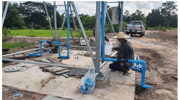
ชุมชนร่วมกันติดตั้งชุดควบคุมหัวน้ำ ตัวกรองน้ำเกษตร (จุดที่ 2) เพื่อกรองเศษดิน เศษหินที่จะเข้าไปในถังบรรจุน้ำ
